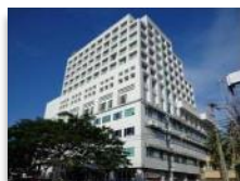
Siloam Hospitals Manado & Hotel Aryaduta Manado
