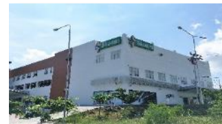
Siloam Hospitals Labuan Bajo
