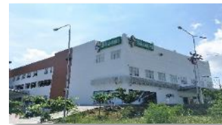
Siloam Hospitals Labuan Bajo
