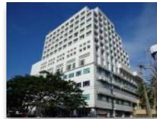
Siloam Hospitals Manado & Hotel Aryaduta Manado
