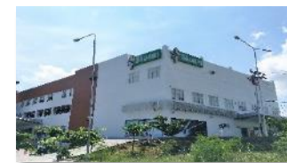
Siloam Hospitals Labuan Bajo
