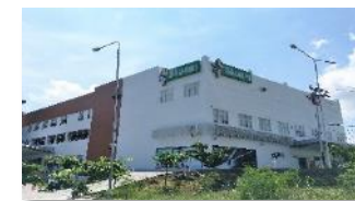
Siloam Hospitals Labuan Bajo
