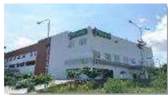
Siloam Hospitals Labuan Bajo
