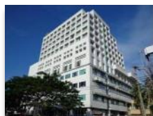
Siloam Hospitals Manado & Hotel Aryaduta Manado
