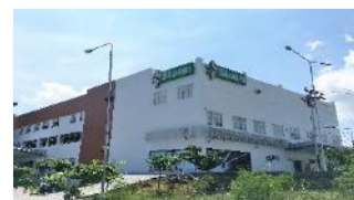
Siloam Hospitals Labuan Bajo
