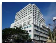
Siloam Hospitals Manado & Hotel Aryaduta Manado
