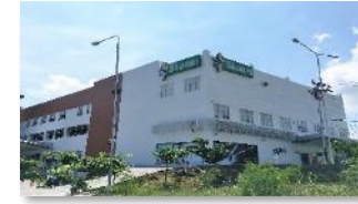
Siloam Hospitals Labuan Bajo
