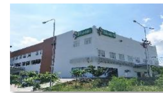
Siloam Hospitals Labuan Bajo
