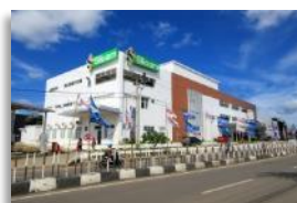
Siloam Hospitals Baubau & Lippo Plaza Baubau
