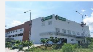
Siloam Hospitals Labuan Bajo
