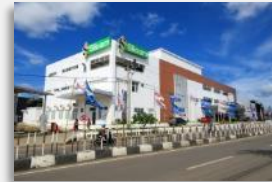
Siloam Hospitals Baubau & Lippo Plaza Baubau
