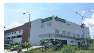
Siloam Hospitals Labuan Bajo
